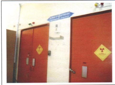
Gambar 3. Verifikasi sistem *interlock* dengan lampu indikator operasi pada Fasilitas Kalibrasi Alat Ukur Radiasi Gamma dan Fasilitas Kalibrasi Alat Ukur Radiasi Sinar-X
