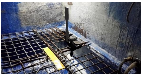
Gambar 2. Peletakan spesimen uji dalam proses sand-blasting
