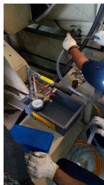
a). Pemasangan pressure test pump
