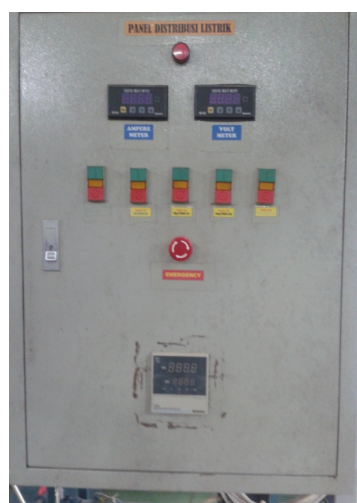
Gambar 8. Panel sistem kelistrikan pada trafo regulator tegangan
