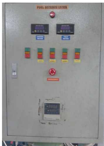
Gambar 8. Panel sistem kelistrikan pada trafo regulator tegangan
