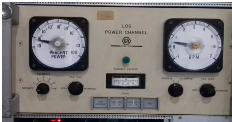
Gambar 11. Alat-ukur persen daya dan periodenya pada posisi START setelah perbaikan, siap operasi.
