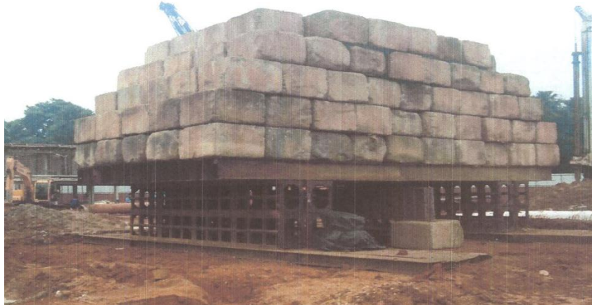
Gambar 2: Dokumentasi Pembebanan AXIAL
