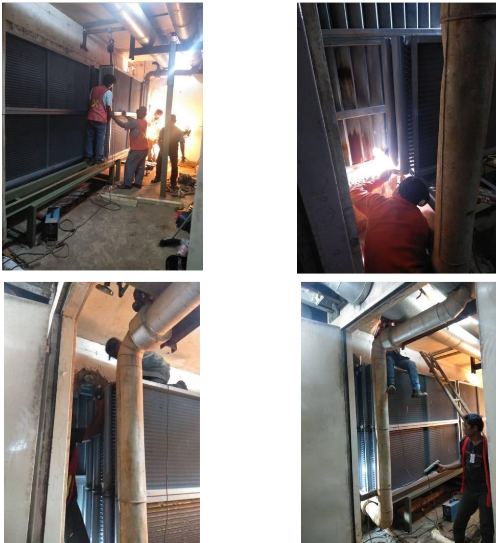
Gambar 11. Tahapan kegiatan pekerjaan penggantian cooling coil sistem VAC laboratorium instalasi Radiometalurgi
