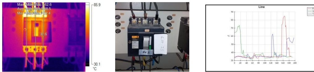
Gambar 3. Pemeriksaan MCB CFE.1B untuk area Basement sebelum perbaikan
