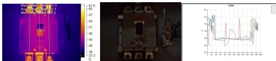
Gambar 6. Pemeriksaan MCCB – Chiller 2B setelah perbaikan
