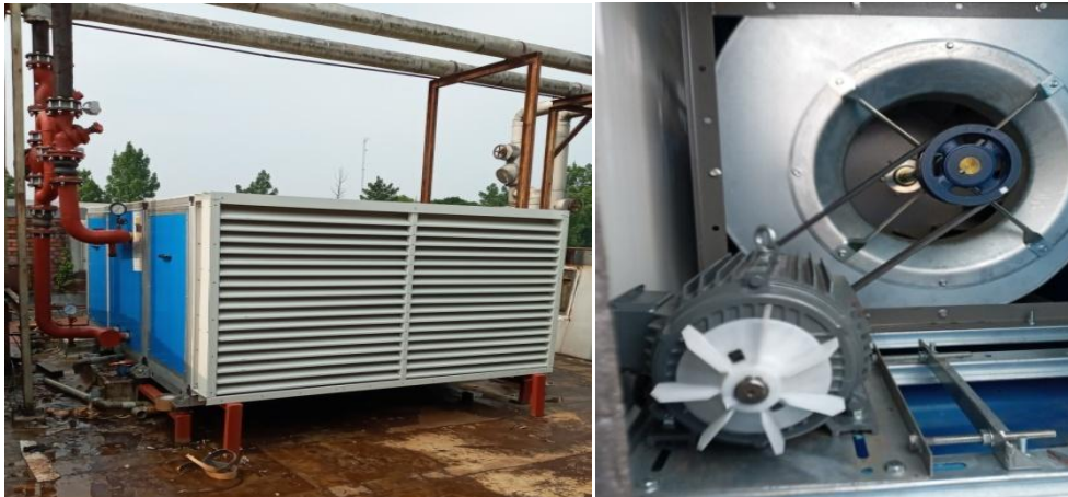
Gambar 13 : Penggantian dengan pemasangan peralatan supply CDT-3 yang baru
