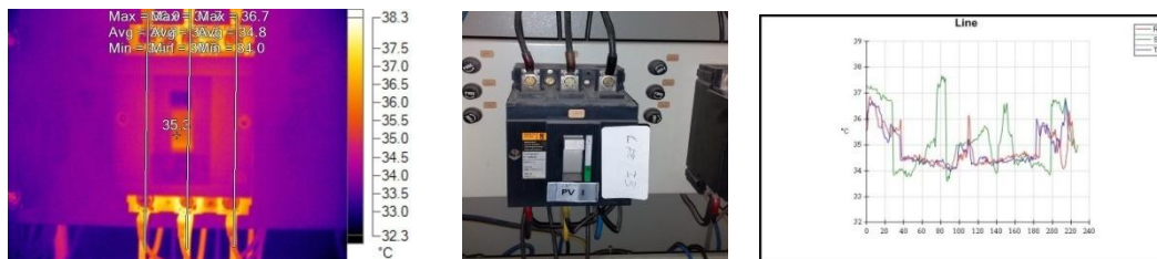
Gambar 4. Pemeriksaan MCB CFE.1B untuk area Basement setelah perbaikan
