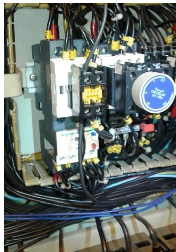
Gambar 6. Kontaktor CDT.5 setelah penggantian
