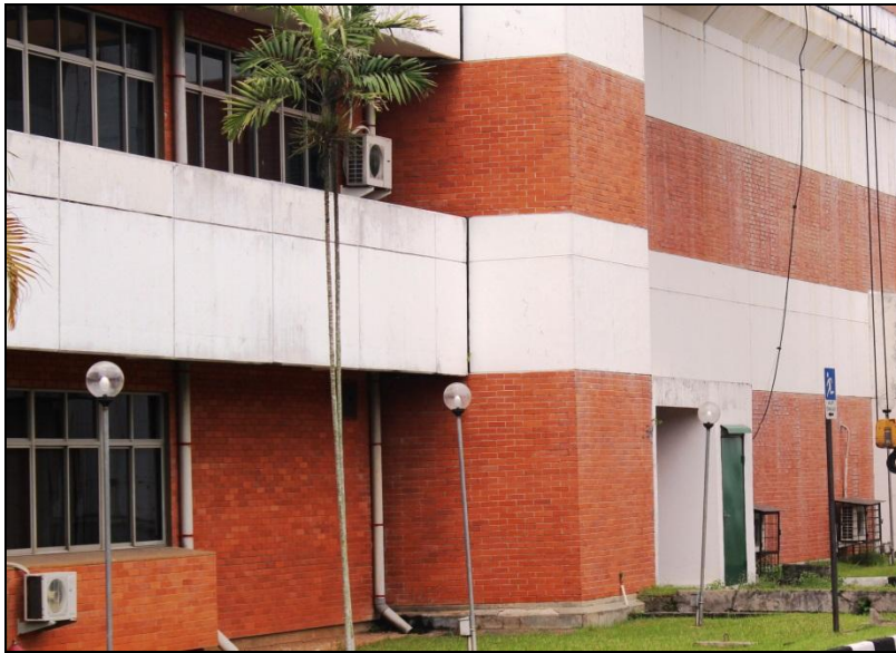
Gambar 5. Sisi gedung IRM, bagian laboratorium berupa dinding beton dan pintu besi tanpa jendela (kanan) dan bagian perkantoran berjendela kaca (kiri).
