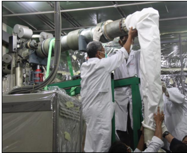
Gambar 4. Pemasangan slave arm unit di ujung wall tube
