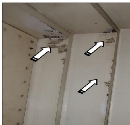
Pada lubang wall plug
