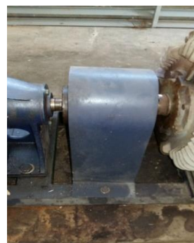
Gambar 2. Plat seng pelindung kopling
