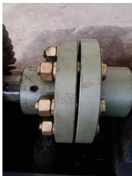
Gambar 10. Kopling pompa Pendingin sekunder selatan
