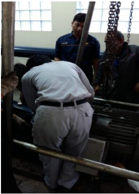
Gambar 3. Pemasangan tackle crane dan kaitannya
