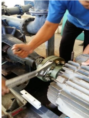
Gambar 9. Mengencangkan kopling
