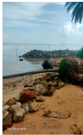
Gambar 7. Foto lokasi proses abrasi dan sebagian diberi penahan gelombang
