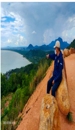
Gambar 8. Foto lokasi abrasi Pantai Pasir Panjang bagian timur ,
