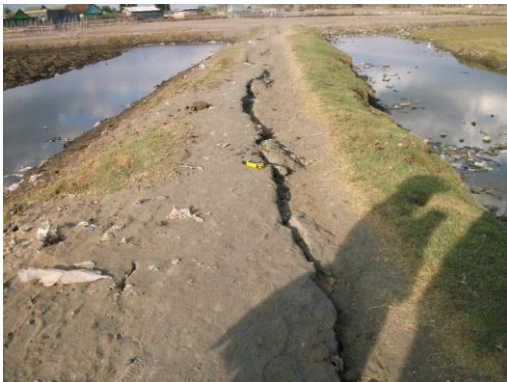
Gambar 13. Retakan tanah berarah timur laut - barat daya di Kampung Bugis, Desa Labuan Mapin, Kecamatan.
