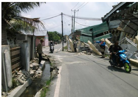
Gambar 3. Contoh bahaya gempa bumi berupa sesar permukaan, yaitu pergeseran mengiri ( sinistral offset ) sebesar 515 cm di Jalan Cemara Indah, Kota Palu sebagai indikasi sesar permukaan akibat gempa bumi tanggal 28 September 2018 [15].
