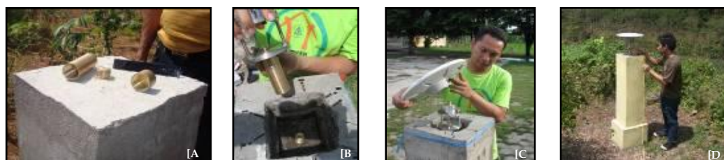
Gambar 5 (a). Screw tanam , (b) Dudukan tribrach , (c) Tribrach , (d) Pilar pengganti tripod .
