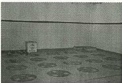
Gambar 3. Tempat Penyimpanan Sementara Limbah Radiasi Tinggi [7,8]
