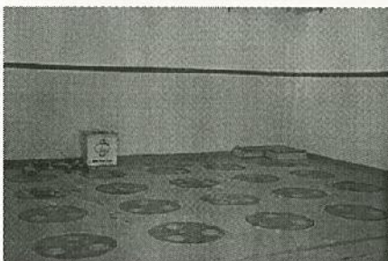
Gambar 3. Tempat Penyimpanan Sementara Limbah Radiasi Tinggi [7,8]
