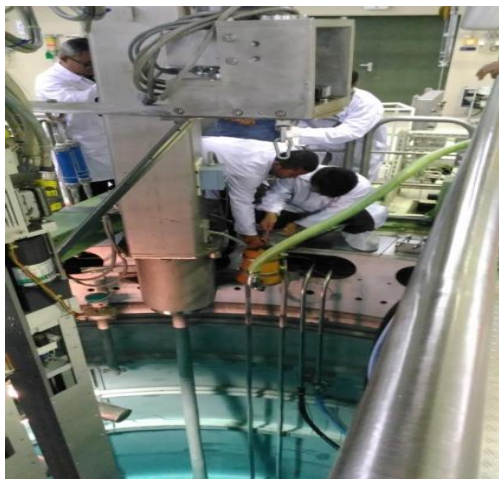
Gambar 1. Pemasangan pompa benam.
