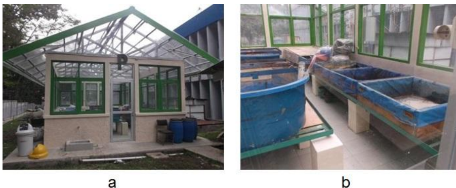
Gambar 1. Green house PSTNT, (a) Tampak luar, dan (b) Tampak dalam
