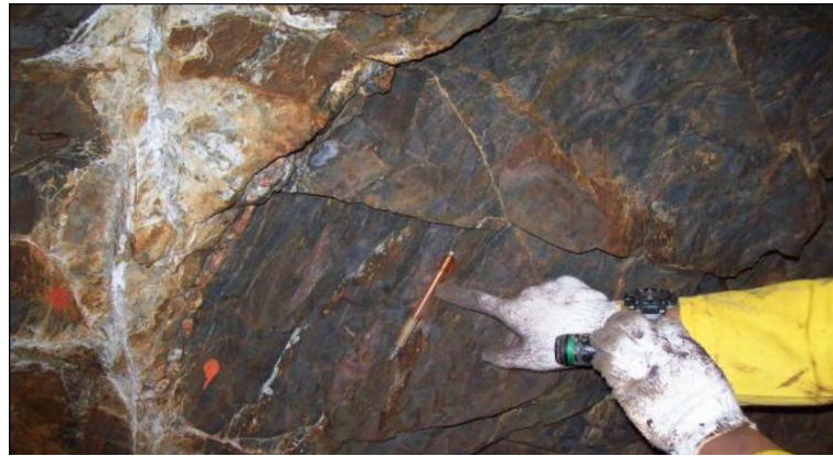
Gambar 6. Pola bidang diskontinuitas kekar dan sekistositas pada batuan metalanau di LP1.
