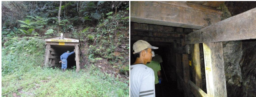
Gambar 2. Mulut terowongan Eko-Remaja (kiri) dan sistem penyangga terowongan menggunakan kayu Keladan (kanan).
