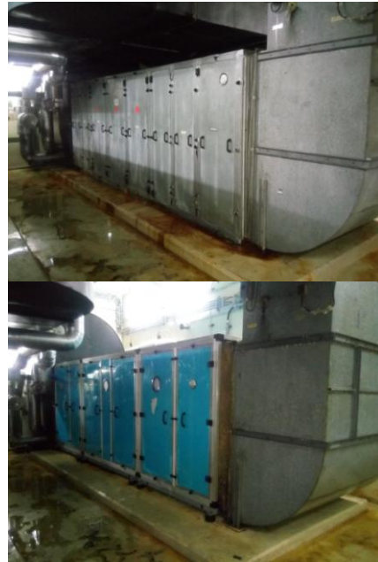
Gambar 8. Kondisi AHU KLA12 sebelum dan sesudah penggantian
