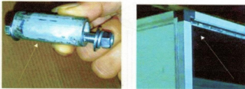
Gambar 4. Peletakan baut pada flange
