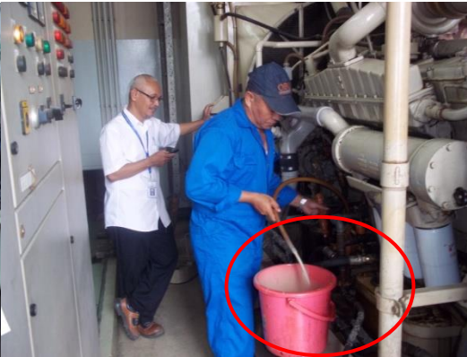
Gambar 3: Pembuangan oli mesin
