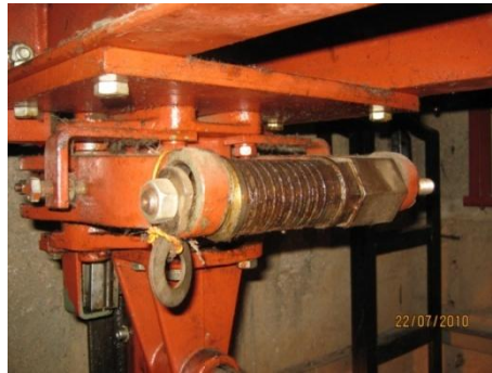
Gambar 6. Test overload pada lift
