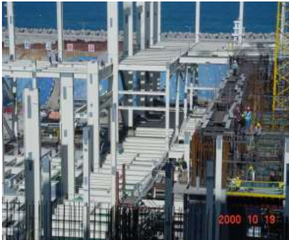
Gambar 1. Penggunaan baja dan struktur baja dalam pembangunan PLTN di Korea Selatan [25]
