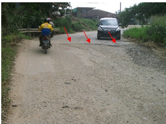
Gambar 6. Retakan Ranah (Tanda Panah Merah) Merupakan Ciri Gerakan Tanah Tipe Rayapan Akibat Beban Material di Atasnya LP 8 (G02).
