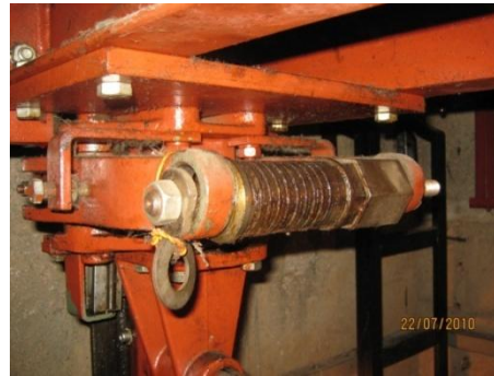
Gambar 6. Test overload pada lift
