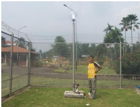
Gambar 5. Perawatan lampu penerangan
